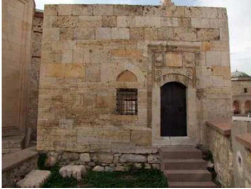
Fotoğraf 23. Yarım Türbe (Kaynak: Konya Vakıflar Bölge Müdürlüğü, Beyşehir Camii ve Külliyesi Sanat Tarihi Raporu)
