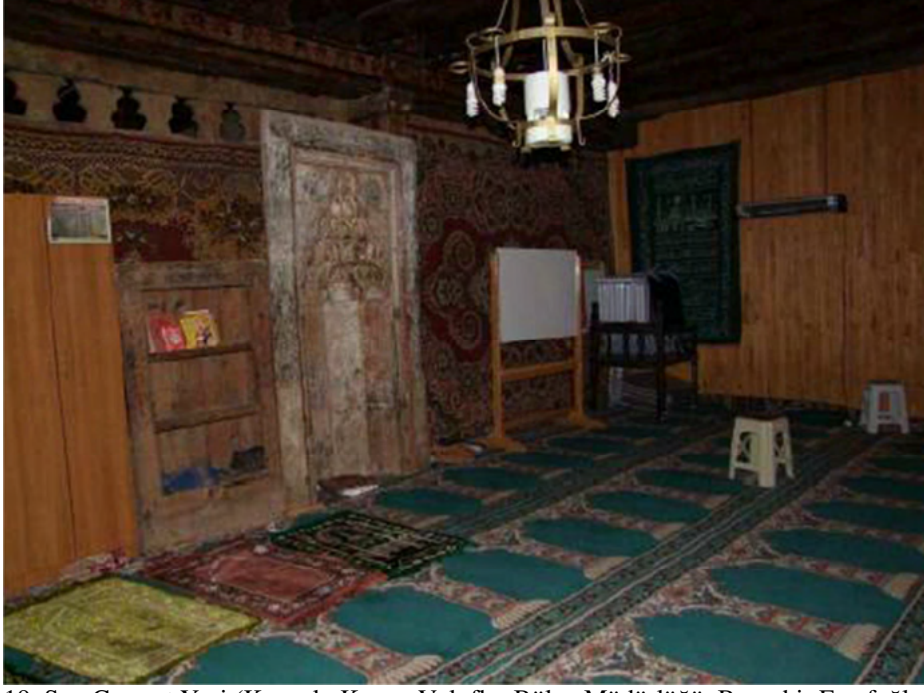
Fotoğraf 19. Son Cemaat Yeri (Kaynak: Konya Vakıflar Bölge Müdürlüğü, Beyşehir Eşrefoğlu Camii ve Külliyesi Sanat Tarihi Raporu)
