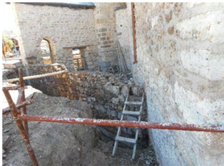
Fotoğraf 25. Drenaj ve İzolasyon Önlemleri (Kaynak: Vakıflar Genel Müdürlüğü Arşivi)
