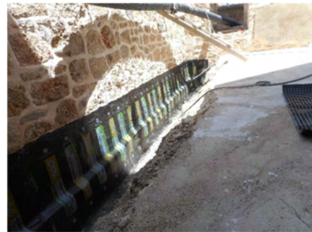
Fotoğraf 25. Drenaj ve İzolasyon Önlemleri (Kaynak: Vakıflar Genel Müdürlüğü Arşivi)
