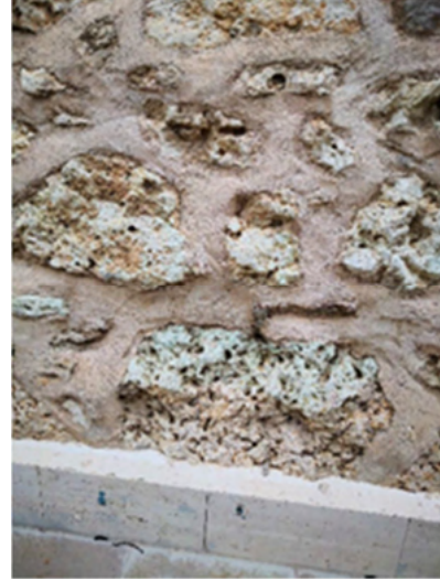
Fotoğraf 26. Taş Yüzeylerde Bozulmalar, 2021 (Kaynak: BAYKAL Pınar, Kültür ve Turizm Bakanlığı)
