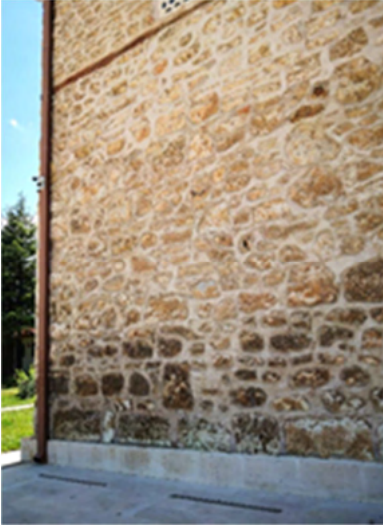
Fotoğraf 26. Taş Yüzeylerde Bozulmalar, 2021 (Kaynak: BAYKAL Pınar, Kültür ve Turizm Bakanlığı)
