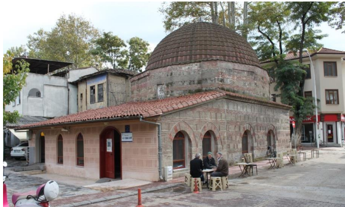
Fotoğraf 21. Hacı Özbek Camii batı ve kuzey cephelerinin görünümü (Kuleli, 2019)
